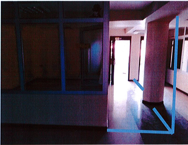
Şekil 3.4.1. Sökülecek doğramalar ve duvar örülecek kısımlar
